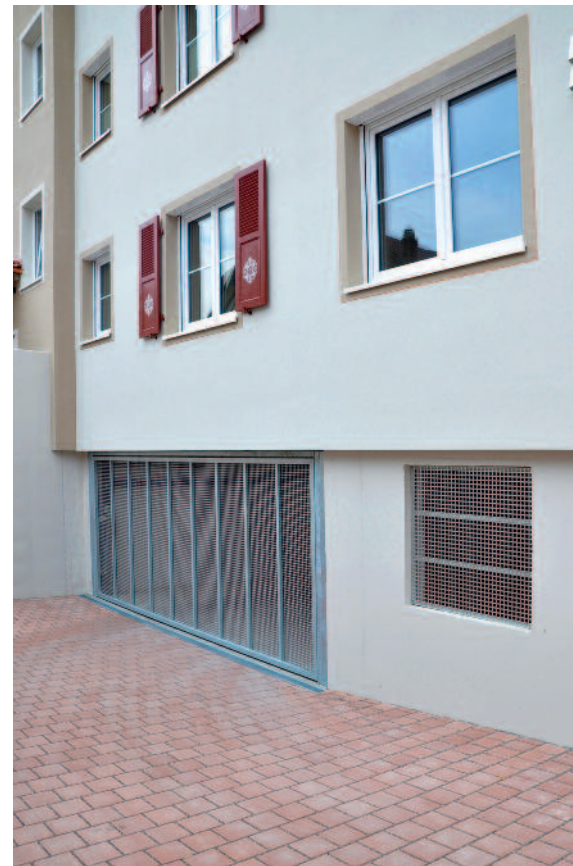
Kipptor mit senkrechten Stäben und Alu-Lochblech hinterlegt
