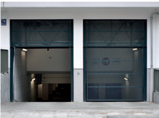
Die Torverkleidung aus Aluminiumblech wurde nach Kundenwunsch mit einem Laser bearbeitet
