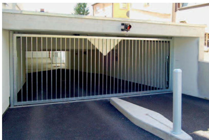
Kipptor mit senkrechten Stäben und Durchgreifschutz für den Torantrieb
