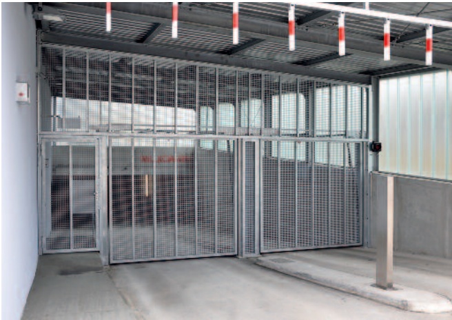
Feuerverzinkte Toranlage mit Nebentüre und Sturzverkleidung
